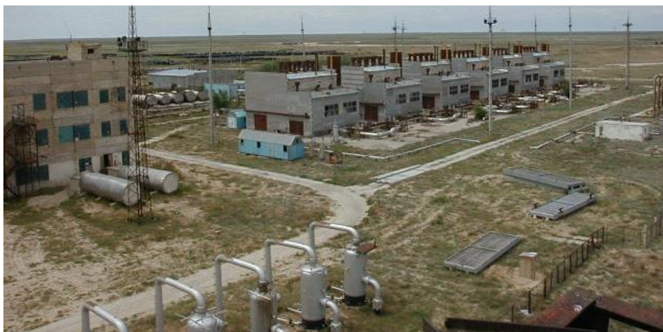
1.1 - сурет – Компрессорлық станция
